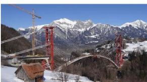
Die Taminabrücke überquert zwischen Valens und Pfäfers die Taminaschlucht in einer Höhe von knapp 200 m. Die 417m lange Brücke besteht aus einem flachen Betonbogen mit einer Spannweite von 260 Metern, einem über Ständer monolithisch verbundenen Überbau und anschliessenden Widerlagerkonstruktionen.
