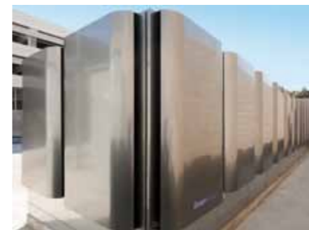
Pile à combustible fabriquée par Bloom Energy pour fourboitelectricité au serveur de eBay et de Google. Une boîte suffit à produire de l'électricité pour environ 100 maisons.
