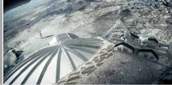
Visualisierung einer Multi-Kuppel-Mondbasis im Bau: Nach der Montage bedecken Roboter die aufgeblasenen Kuppeln mit einer Schicht aus 3D-gedruckten Mondregolith, welche die Bewohner vor der Weltraumstrahlung und Mikrometeoriten schützt. Bildquelle: ESA/Foster + Partners
