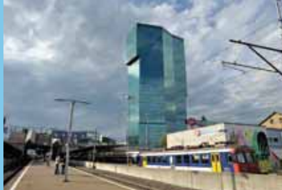
La stazione Zurigo Hardbrücke si trova al centro del quartiere di Zurigo Ovest, in forte espansione.
