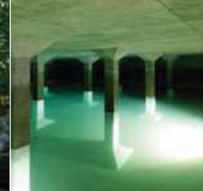
L'eau est stockée temporairement dans des réservoirs d'eau potable.
