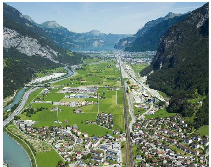
Abbildung 2: Baustelle Neat-Portal Erstfeld
