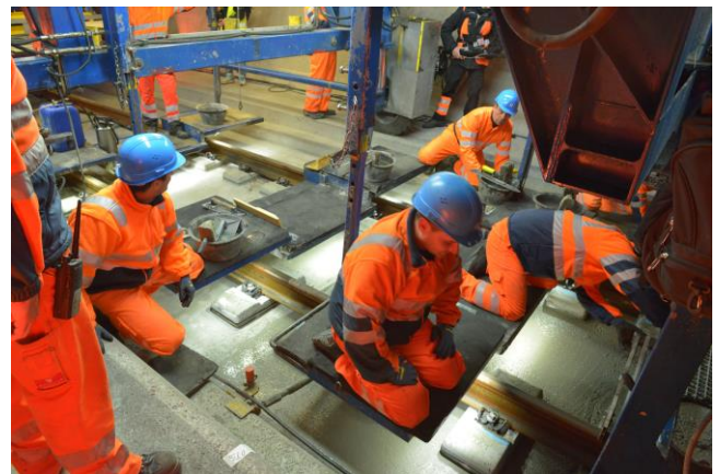
Abbildung 3: Einbau der festen Fahrbahn
