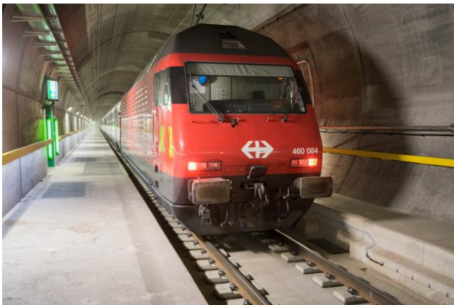
Abbildung 4: Inbetriebsetzung Gotthard Basistunnel
