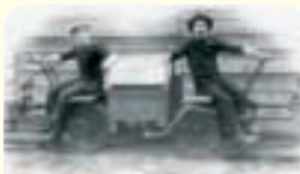
L'approvisionnement en explosifs à l'aide de drains
